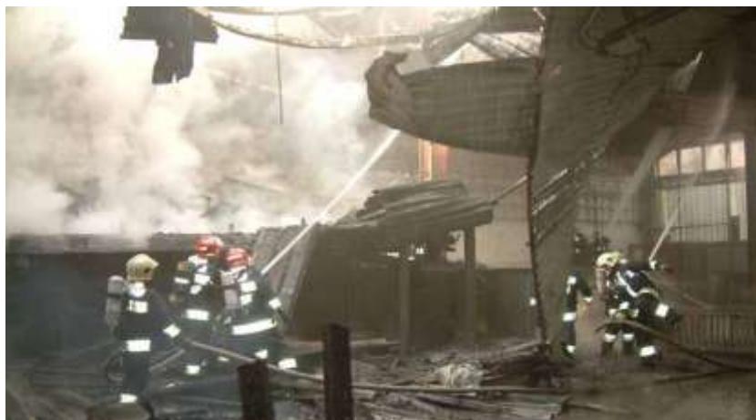
6. ábra. Acél trapézlemez tetőfödém maradványai egy gyártócsarnok tüzesete után. Műanyagtűz, a tűzfészek fölötti tetőfödém-szakasz leomlott [7]
