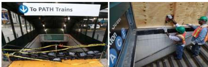
10. ábra. Balról: homokzsákkal védték a Hoboken-i vasút PATH állomását. Jobb oldali kép: a Közlekedési Hatóság emberei Canal Street A, C, és E-állomást fedik be rétegelt falemezzel október 27-én (New York) [14]
