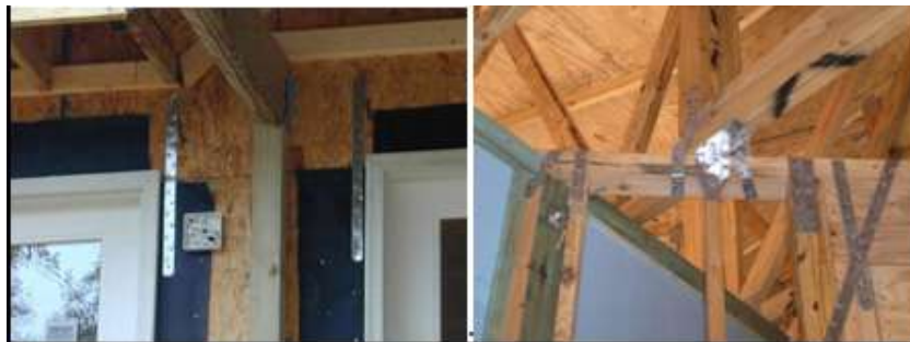
2. ábra. Tetőszerkezet megerősítése hurrikán hatásainak csökkentése érdekében [3]
