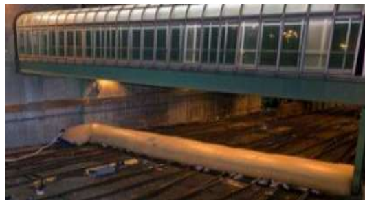
9. ábra. Az árvízi elöntés ellen vizes gátat emeltek a Long Islandi Vasút síneknél [13]
