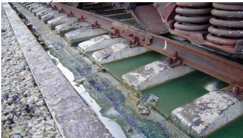
3. ábra: Az egyik telítődött vízelvezető-csatorna [19]
