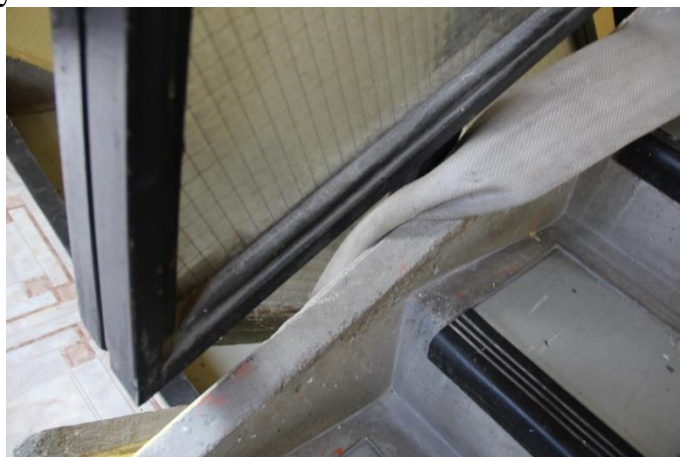
2. kép A korlát alá szorult tömlő (forrás: Vincze Zsolt Készült: Budapest, 2013.október 11.)
