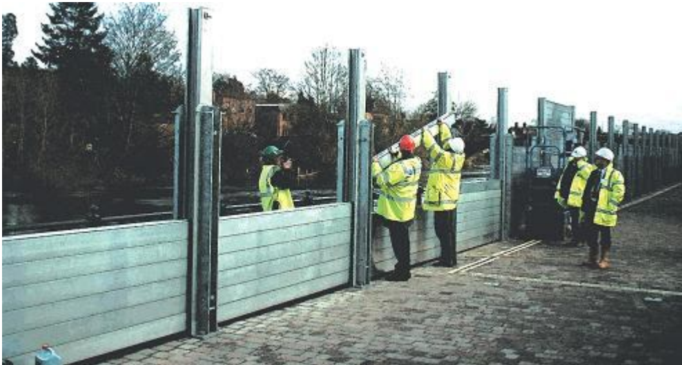
2. ábra. IBS fal építése
