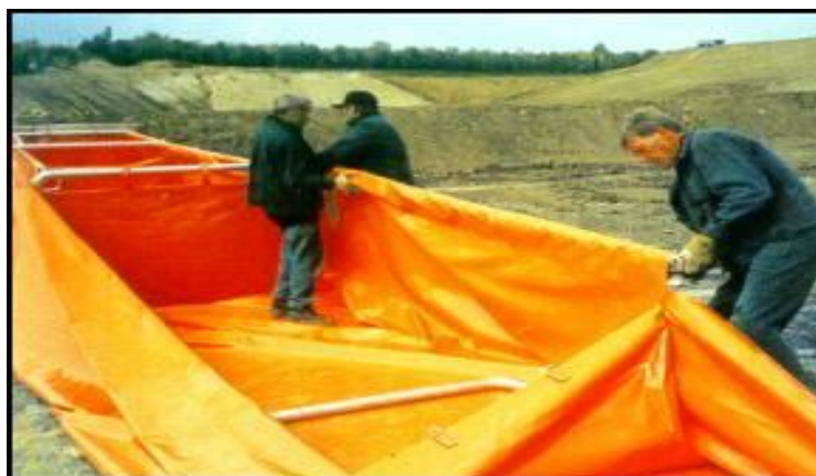
5. ábra. Mobilgát szerelés
