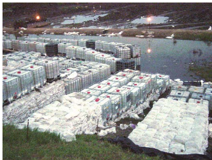
3. sz. kép: Bordás megtámasztás tartályokkal. (Készítette: Török László mk. alez.)
